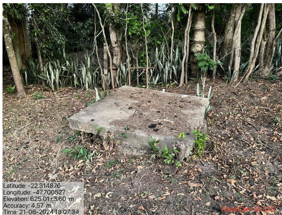
FIGURA 49 –Tampa de fossa séptica no bairro Itapé em Corumbataí - SP
