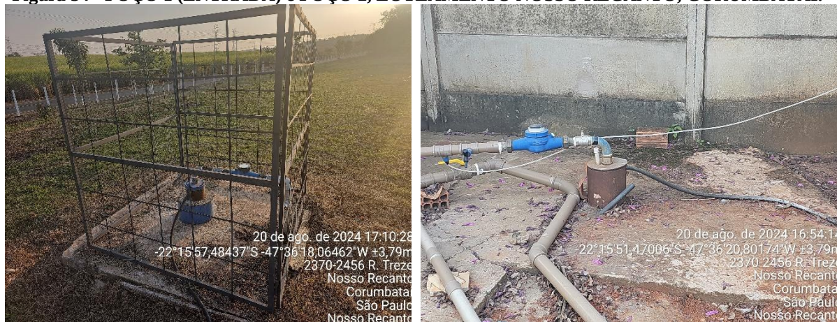
Figura 34 - POÇO 1 (ENTRADA) e POÇO 2, LOTEAMENTO NOSSO RECANTO, CORUMBATAÍ.
