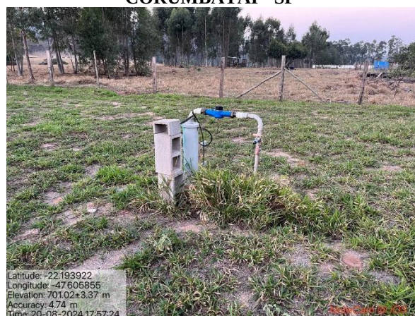
FIGURA 39 - POÇO EM PROPRIEDADE NO LOTEAMENTO DE CHÁCARAS EM CORUMBATAÍ - SP
