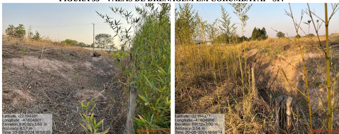
FIGURA 53 - VALAS DE DRENAGEM EM CORUMBATAÍ - SP.
