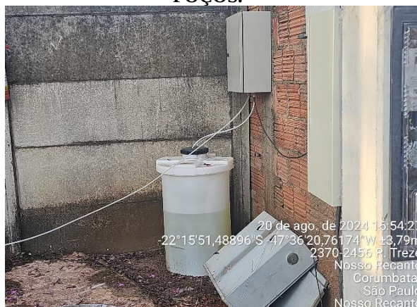
Figura 36 – CLORAÇÃO DA ÁGUA DOS POÇOS.
