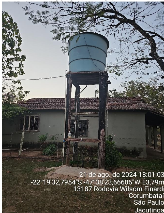
FIGURA 41 - RESERVATÓRIO DE ÁGUA DE UMA PROPRIEDADE EM JACUTINGA, CORUMBATAÍ-SP.
