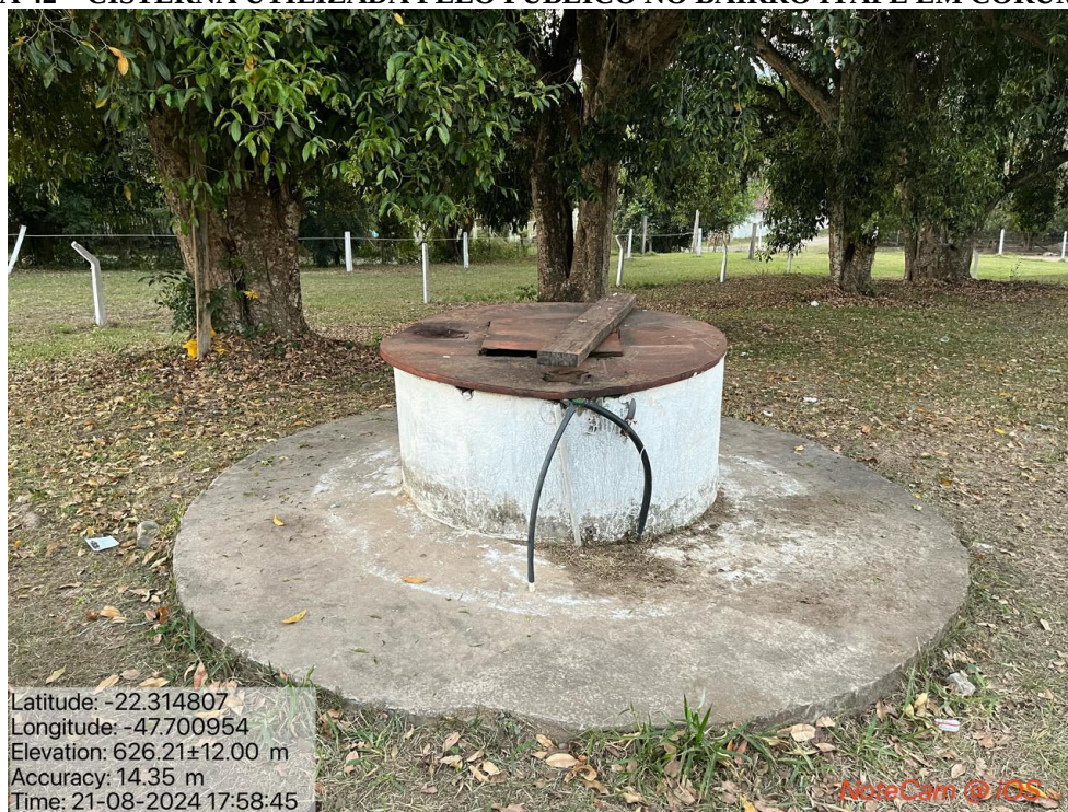
FIGURA 42 – CISTERNA UTILIZADA PELO PÚBLICO NO BAIRRO ITAPÉ EM CORUMBATAÍ.
