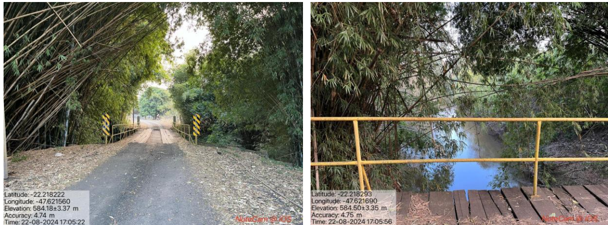
FIGURA 27 – PONTE DE ACESSO AO BAIRRO CANHONI POR CIMA DO RIO CORUMBATAÍ
