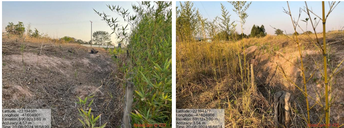
FIGURA 26 - VALAS DE DRENAGEM EM CORUMBATAÍ - SP.
