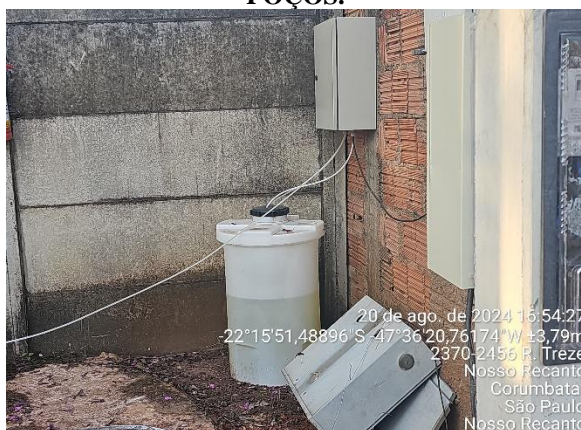
FIGURA 9 – CLORAÇÃO DA ÁGUA DOS POÇOS.
