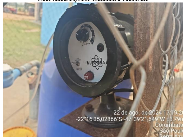
FIGURA 17 - DOSADOR DE CLORO DA MINERAÇÃO SERRA AZUL.
