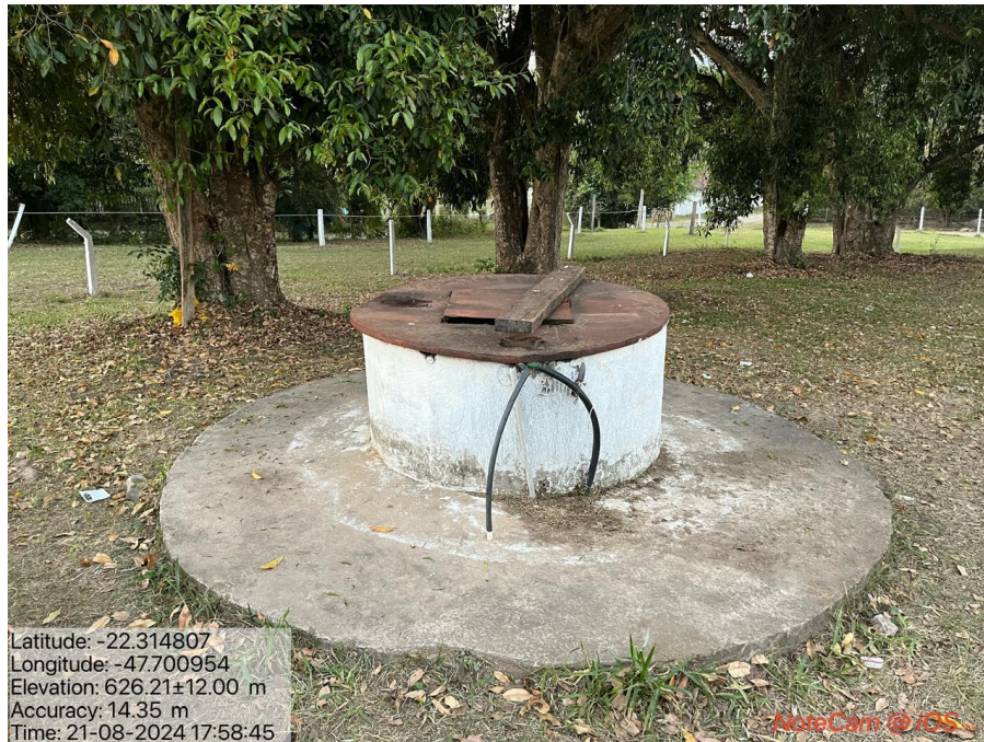
FIGURA 15 – CISTERNA UTILIZADA PELO PÚBLICO NO BAIRRO ITAPÉ EM CORUMBATAÍ.
