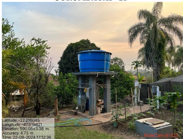
FIGURA 18 – RESERVATÓRIO EM PROPRIEDADE NO BAIRRO CANHONI EM CORUMBATAÍ - SP
